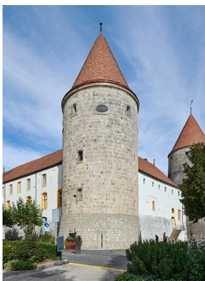
19. Tour des Juifs [D] 2021 avant travaux (R. Gindroz)
