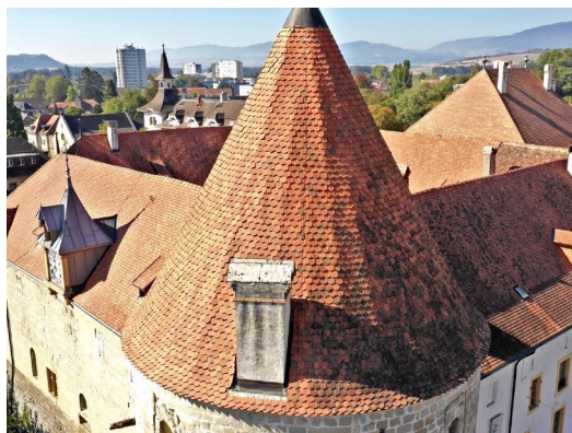
31. Tour des Gardes [B], état de la cheminée lors de l'intervention à la nacelle, 21/03/2023 (Rovero)
