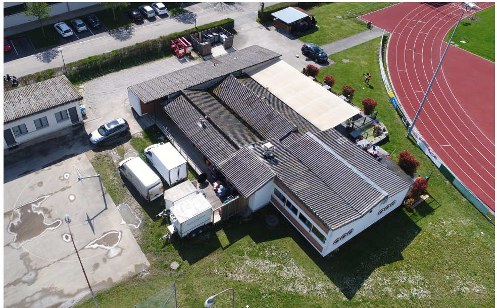
Vue aérienne du bâtiment
