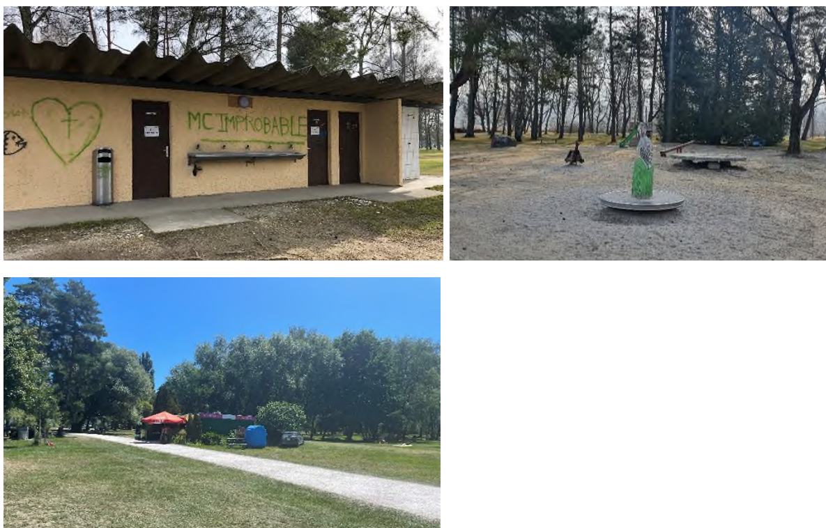
Fig .2-3-3bis : Les sanitaires, la place de jeux et le kiosque sur le secteur de la plage (2022)
