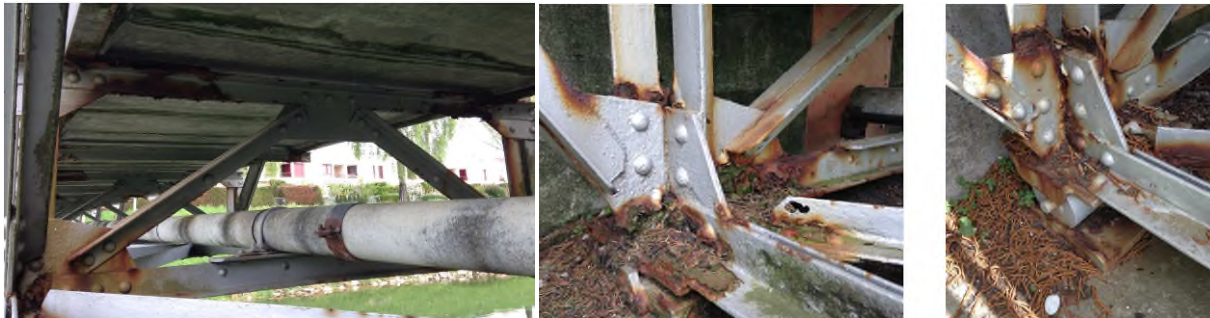
Figure 4 : Vue état entretoises et appuis
