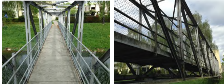
Figure 3 : Passerelle des Tilleuls
