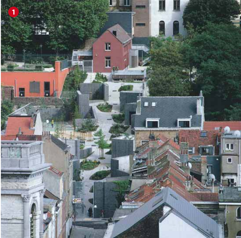
Exemple de renouvellement urbain assurant les continuités piétonnes dans le quartier Parc Reine-Verte à Schaerbeek (Belgique) - Erik Dhont
