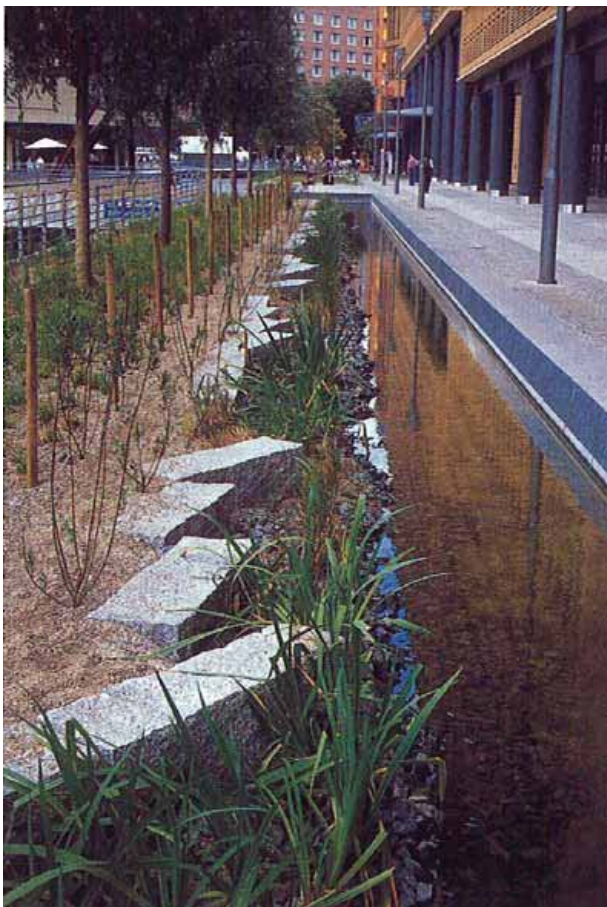
Rigole de récolte et de rétention des eaux de toitures Postdamer Platz à Berlin
