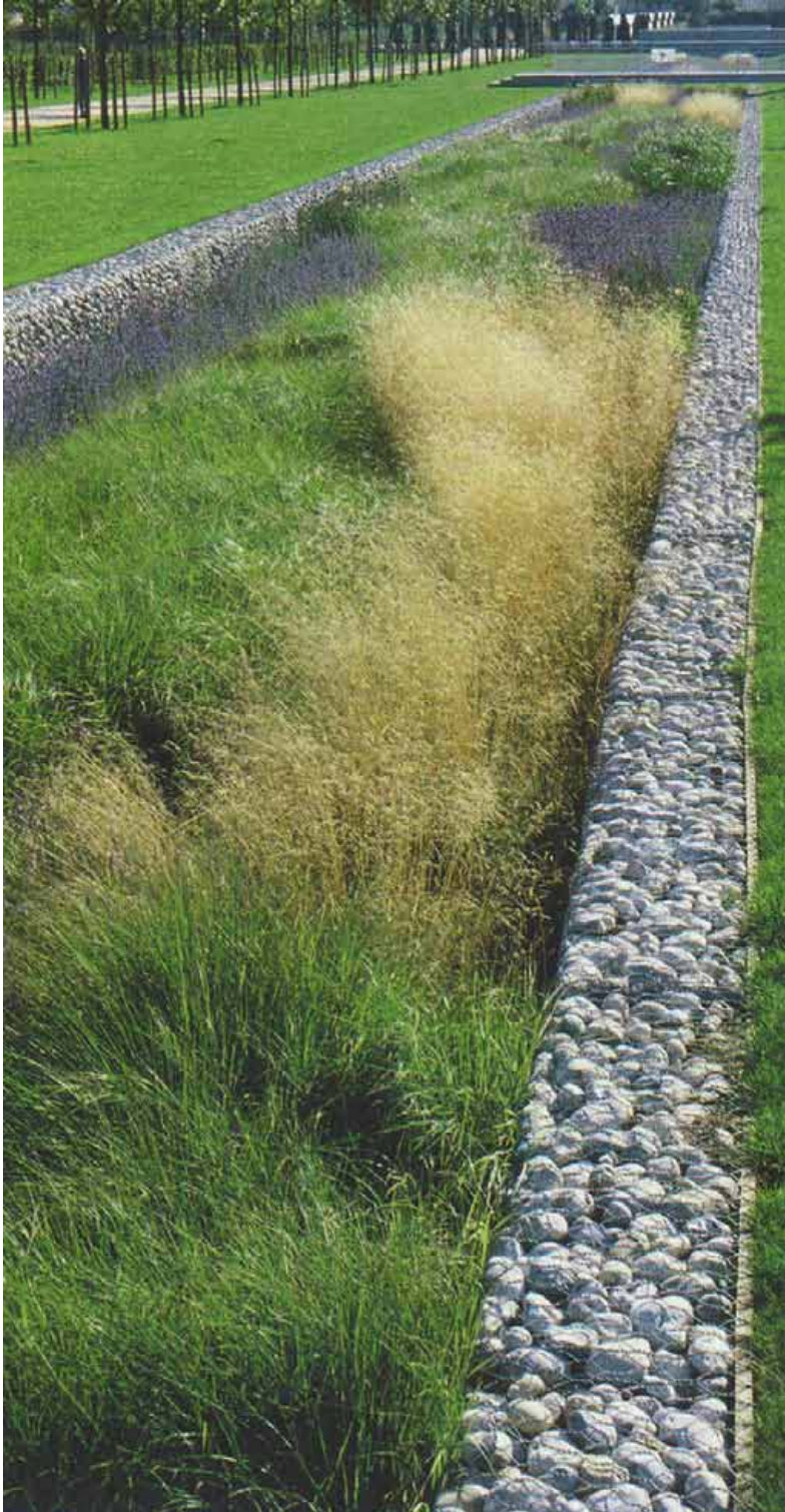
Noue de récolte des eaux du Parc des Lilas Vitry-sur-Seine (France) - Florence Mercier
