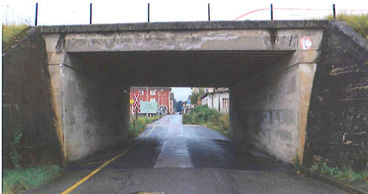
RUE DE L'INDUSTRIE COMMUNE D'YVERDON-LES-BAINS
